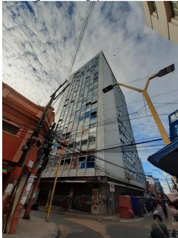
Figura 33 - Antigo prédio do INSS
