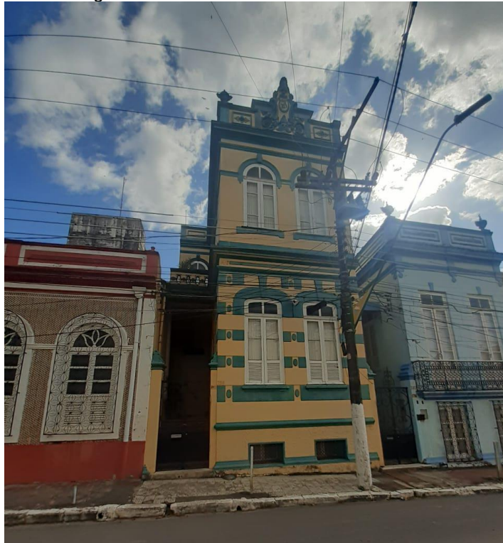
Figura 32 - Prédio na 7 de setembro nº 170
