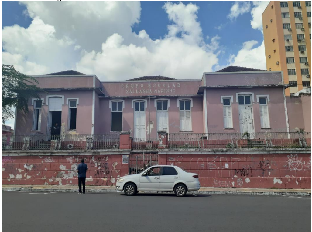
Figura 12 - Fachada da Escola Estadual Saldanha Marinho
