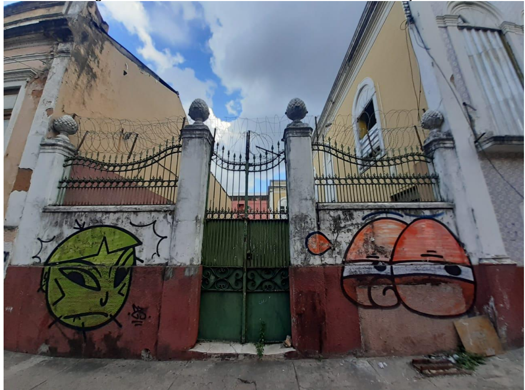
Figura 23 - Portão Lateral da Escola Estadual Nilo Peçanha
