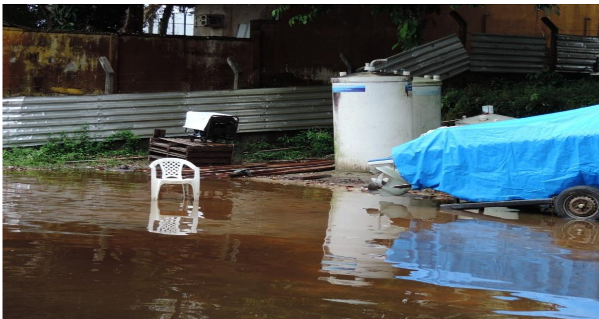
Figura 25 -Sistema Modular Tratamento de Esgoto
