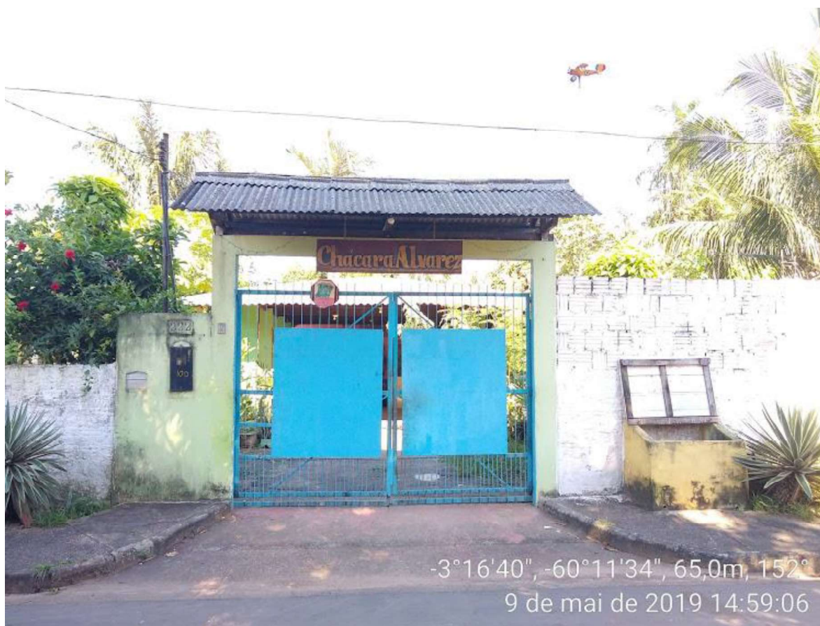
Figura 17: Residência na zona urbana de Iranduba/AM – Chácara Alvarez.
