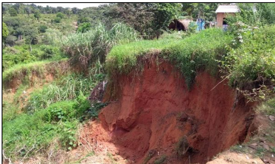
Figura: 08 e 09 – Voçoroca próximo a moradias na V. Caburi. Fonte: Pesquisa de Campo, 2018.
