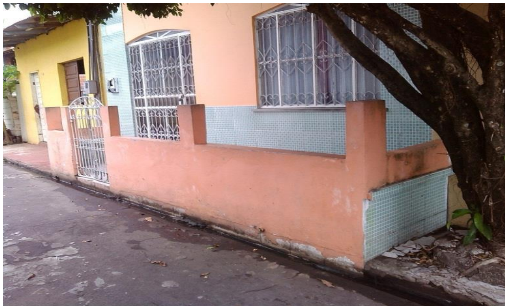
Figura 8: Construção irregular- Parintins
