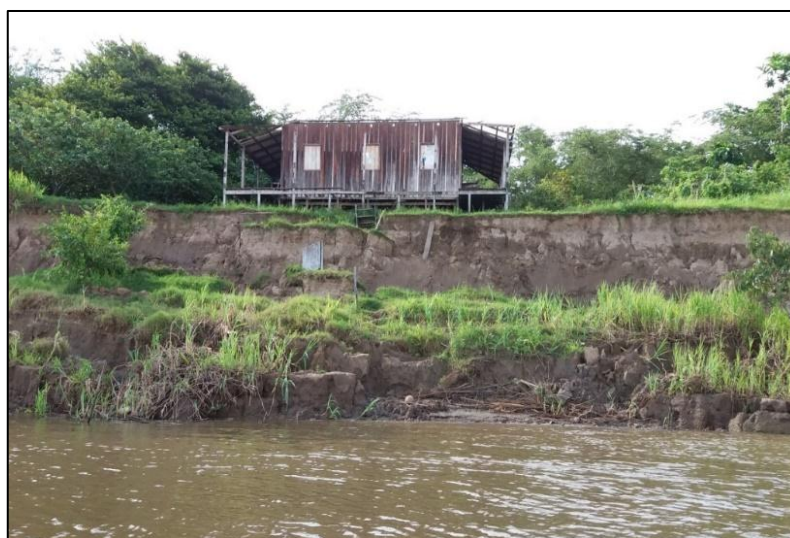
Figura 14: Residência afetada pelas terras caídas na área de estudo.
