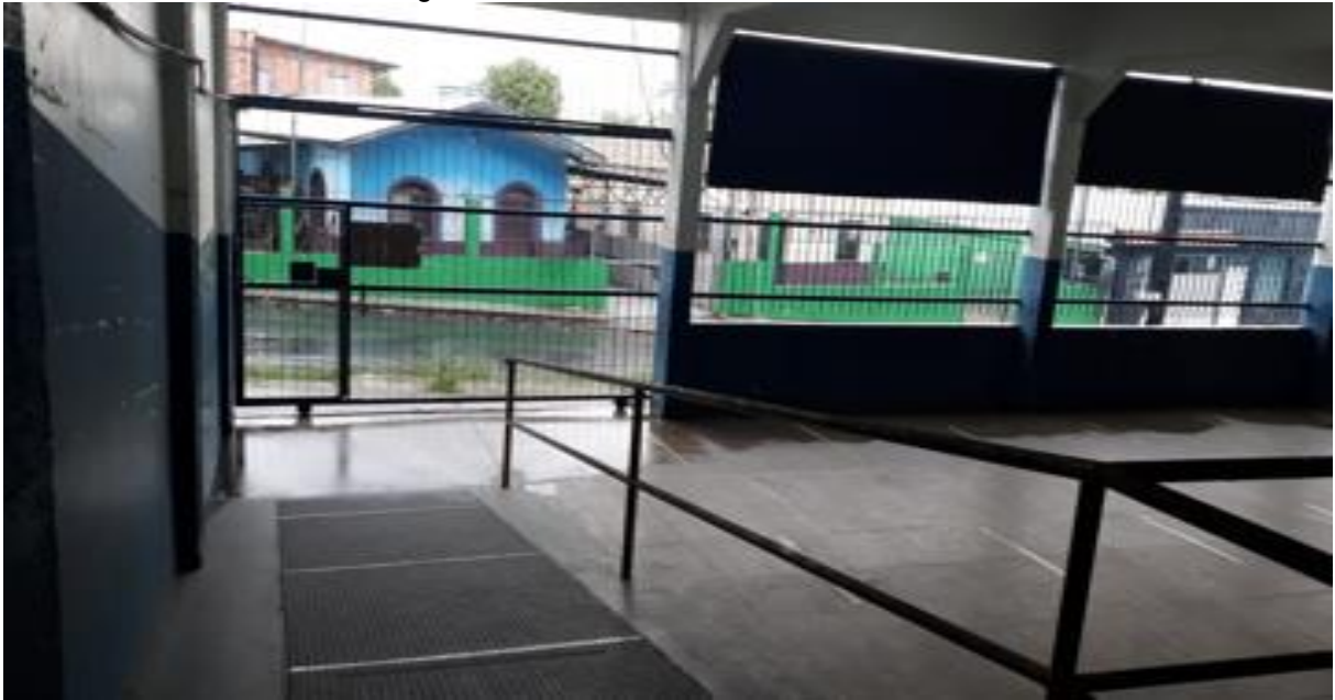
Figura 2 - Área interna escola - entrada.
