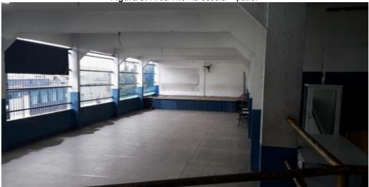
Figura 3: Área interna escola – pátio.
