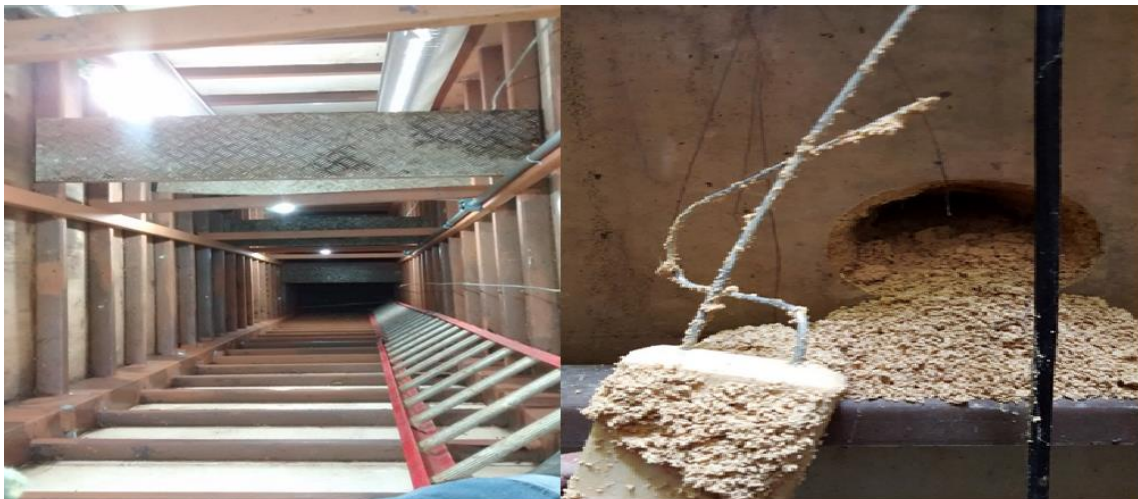
Figura 2 – Estrutura interna do poço e o local da amostragem
