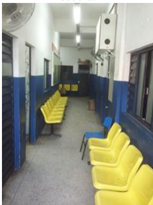
Figura 4: Corredor que serve como pátio da escola.
