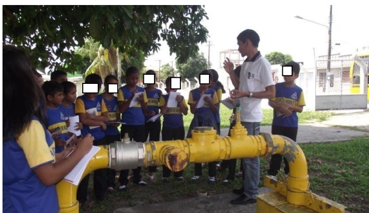
Figura 5: Aula na Estação de Tratamento de Água de Parintins Fonte: Carmen Santos 2011
