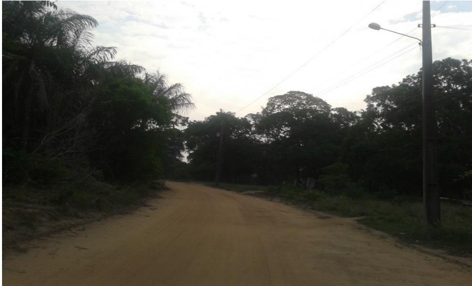
Figura 6: Parte da estrada de terra com fios elétricos e com luminárias nos postes.
