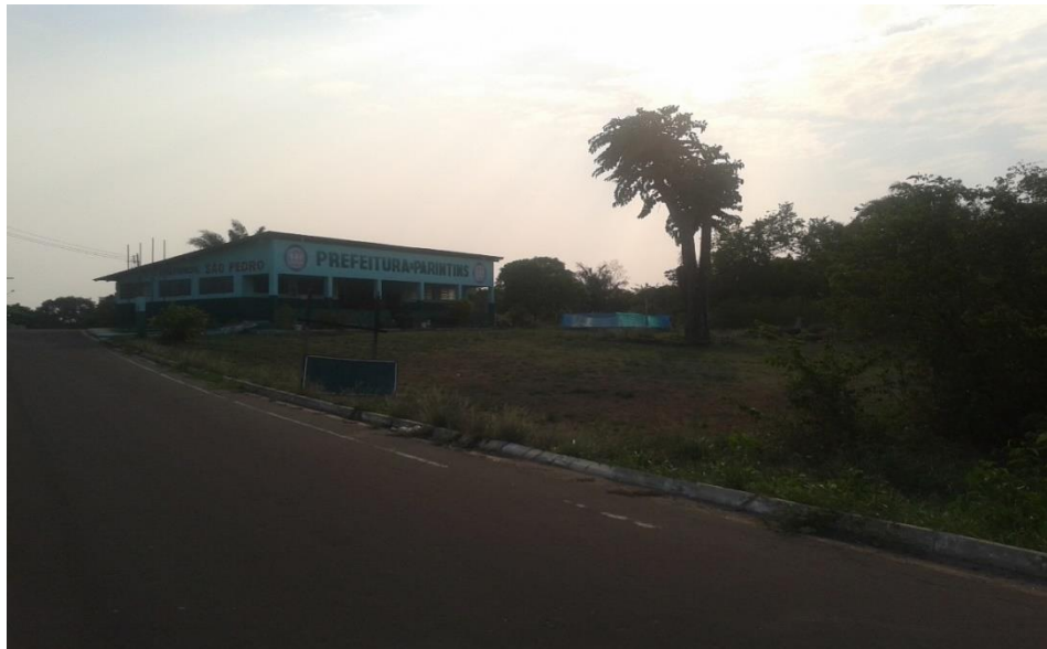
Figura 14: Prédio da escola São Pedro do Paranema.
