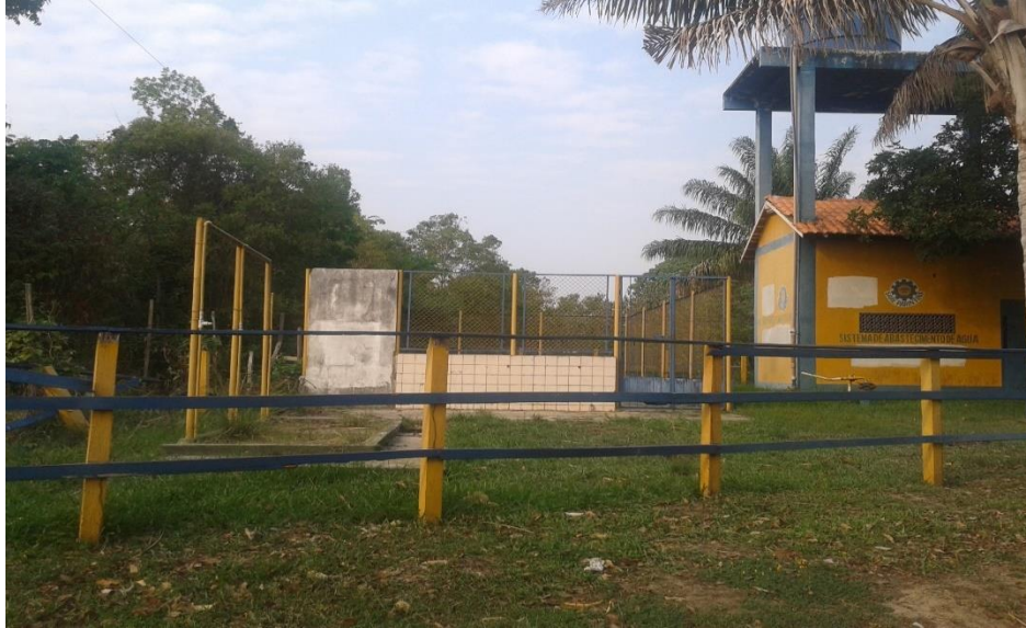
Figura 9: Estação da rede de abastecimento e distribuição de água na comunidade do Parananema.
