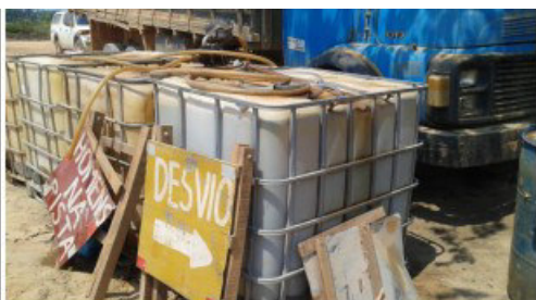
Armazenamento de combustível em vasilhames plásticos
