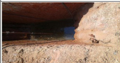
Poço de água potável (a céu aberto)
