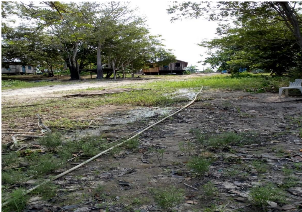
Figura 21- Captação de água superficial por meio de bomba submersa na Comunidade São Francisco do Mainã (margem esquerda), Bacia do Rio Puraquequera (AM)
