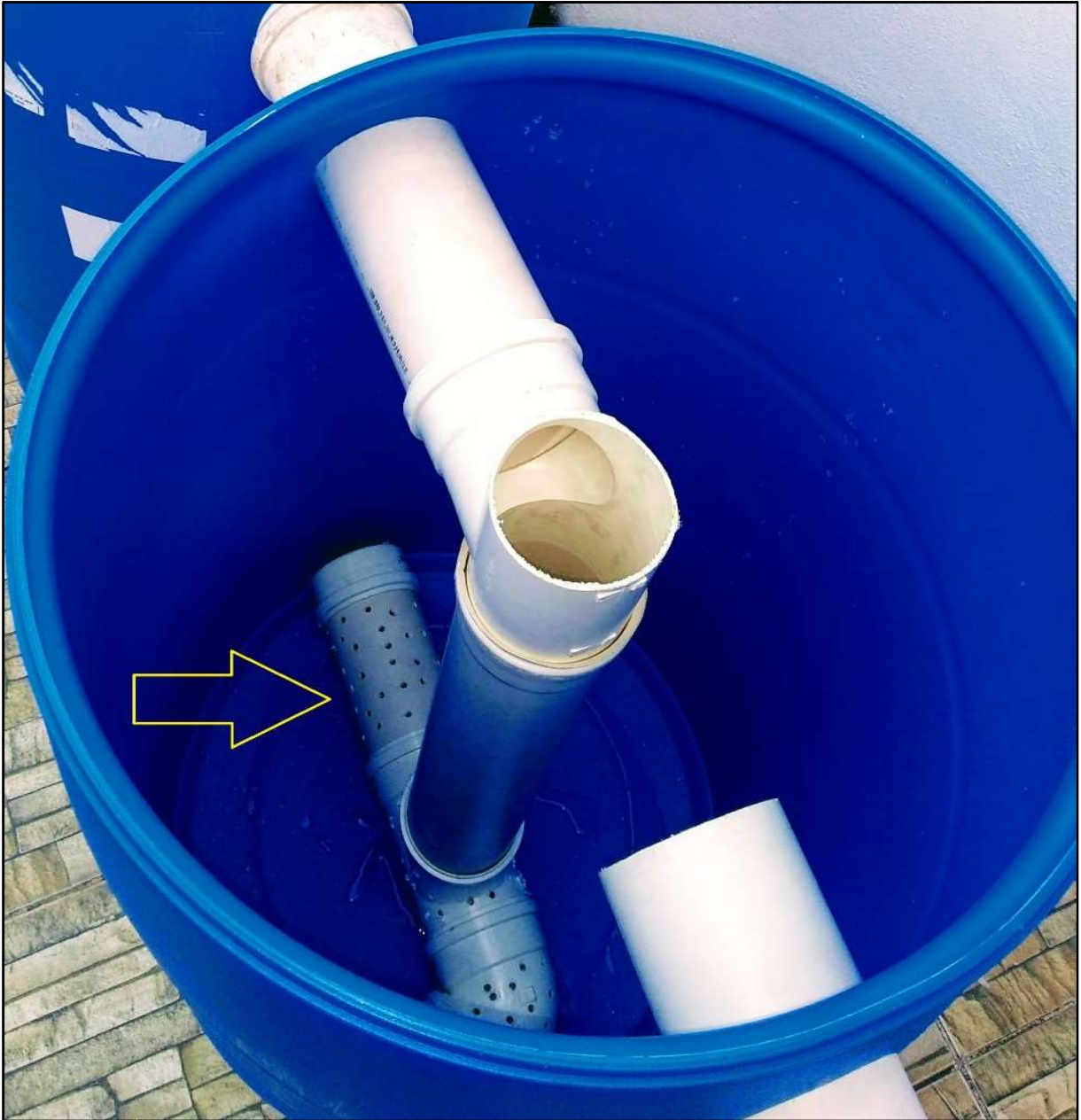
Figura 17 - Mecanismo de entrada do efluente no segundo tambor, Manaus – AM.
