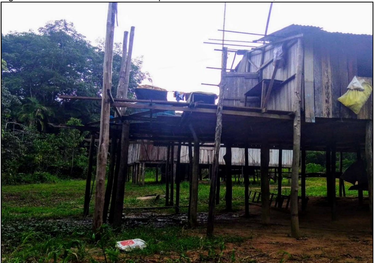
Figura 11 - Domicílio construído em palafitas sem saneamento, Iranduba – AM.
