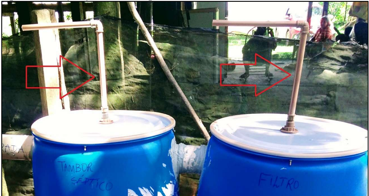
Figura 18 - Suspiro para saída de gases, Manaus – AM.
