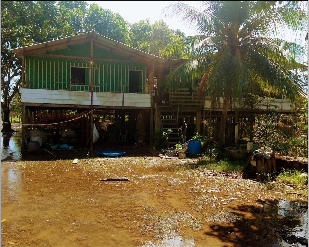
Figura 14 - Residência típica de comunidades ribeirinhas amazônicas onde foi instalado o TSB, Iranduba – AM.
