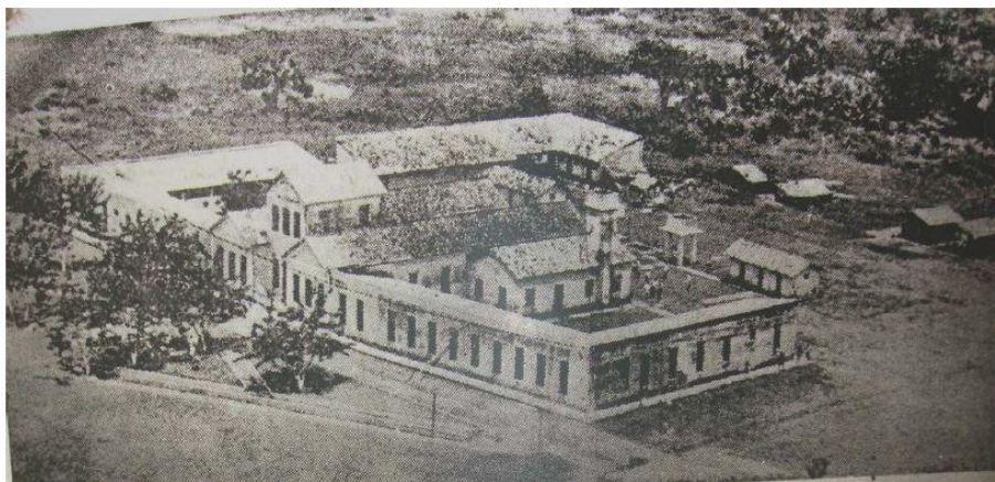
Fotografia 7: Prédio do Educandário Nogueira de Faria pronto para inauguração na década de 1930, com destaque para boa infraestrutura e pouca ocupação humana Fonte: A Província do Pará (1973)
